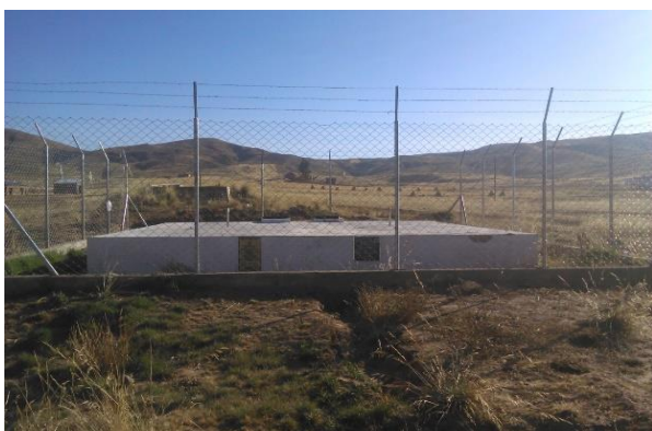
TANQUE DE ALMACENAMIENTO (100 M3)
