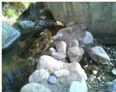
OBRA DE TOMA
