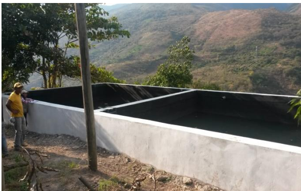
TANQUE DE ALMACENAMIENTO
