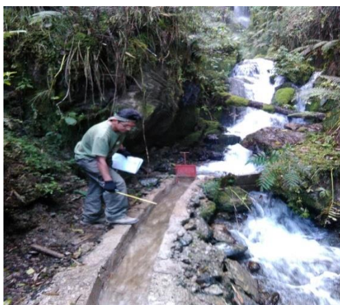
OBRA DE TOMA
