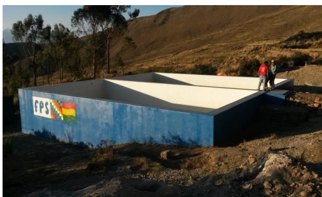
TANQUE DE ALMACENAMIENTO (300 M3)
