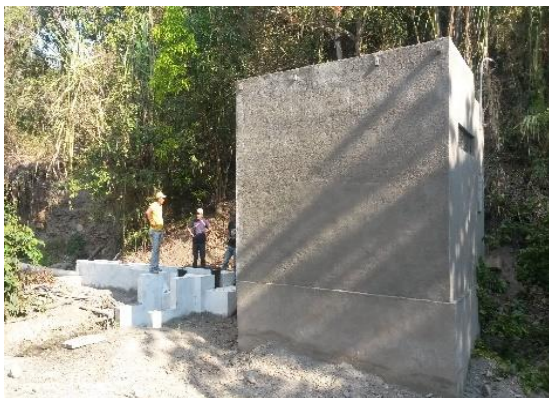
OBRA DE TOMA POR BOMBEO
