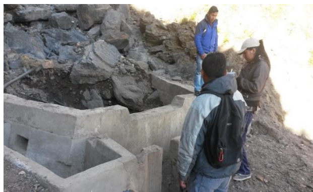
OBRA DE TOMA
