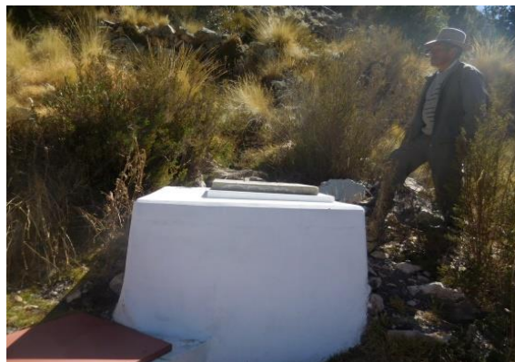
OBRA DE TOMA
