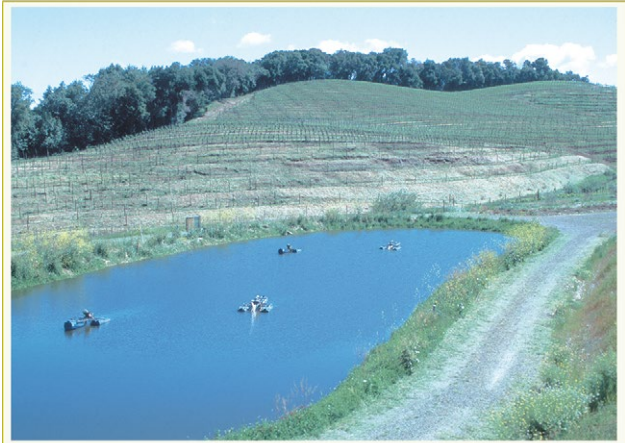
Foto 10. Cubetas de detención para amortiguar escurrimientos y decantar sedimentos
