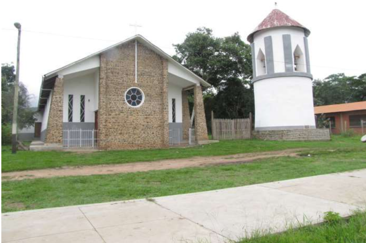
Figura 10. Iglesia y torre de Covendo. (Foto: Enrique López)
